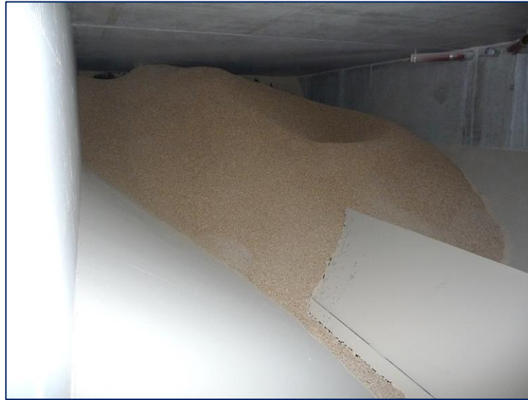
Pelletlager unterirdisch Beton
