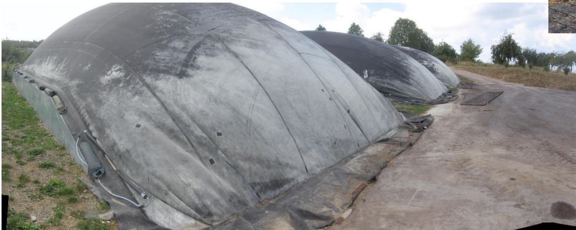
Kleinbiogasanlage für Pferdemist und weitere Feststoffe
