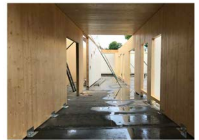
Baustellen Foto, ZRS Architekten Ingenieure
