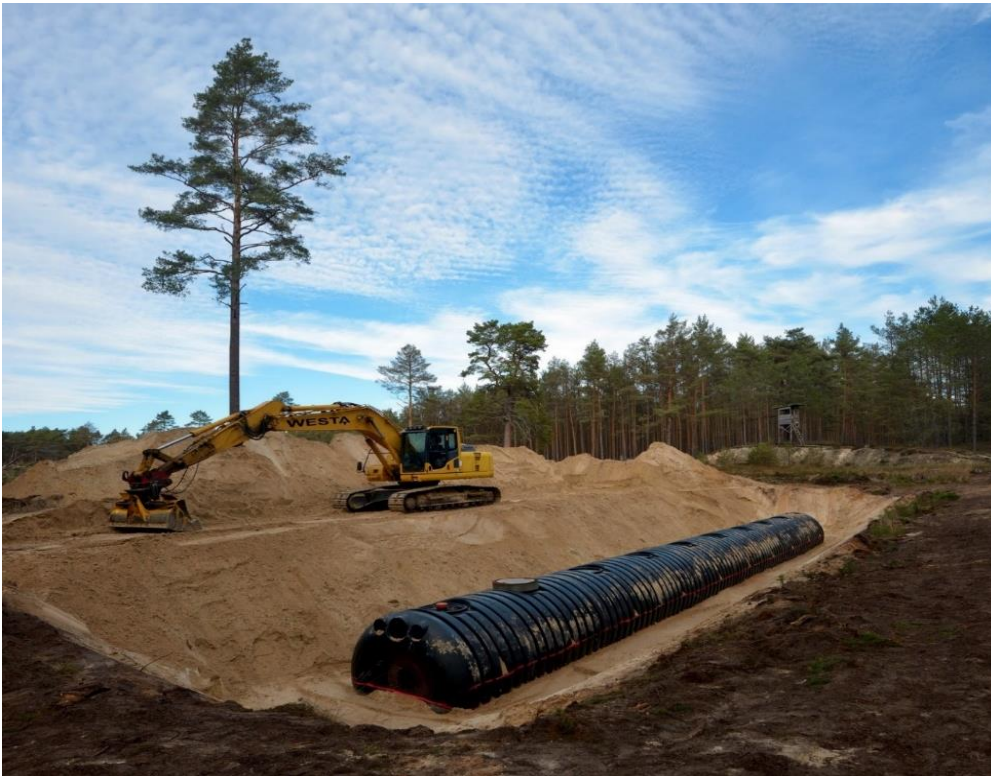
Errichtung einer Löschwasserzisterne am Waldbrandriegel im Forstamt Kaliß (Foto: THOR, 2022)
